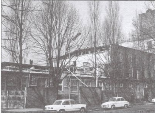
Rozbiórka starych pomieszczeń Katedry TMM.
