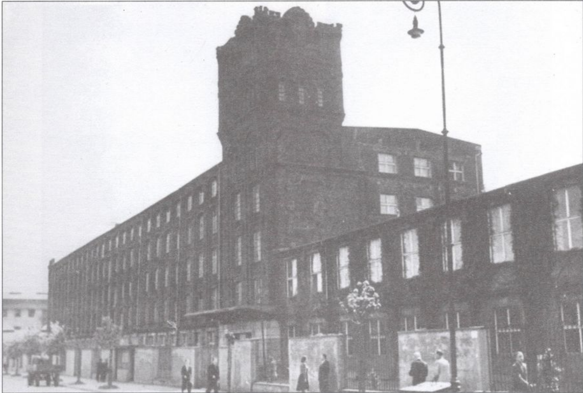
Budynek Główny, siedziba późniejsza Katedry – pomieszczenia na parterze budynku ( na lewo od wejścia). Rok 1949.
